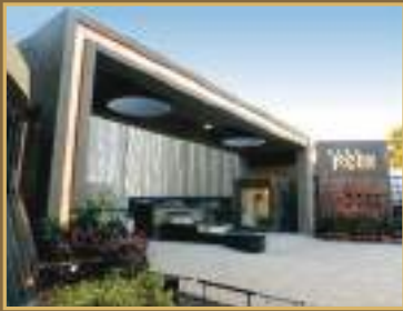
ISCON HARMONY, VADODARA
