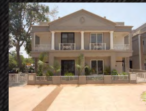
ISCON VILLAS, A'BAD
