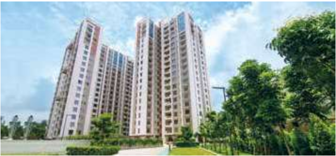
Ozone South EM Bypass
