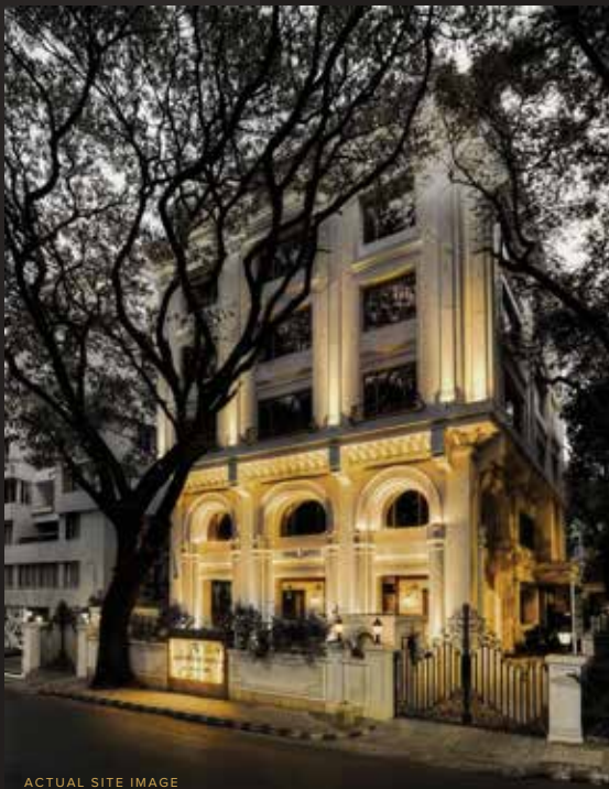
ACTUAL SITE IMAGE
