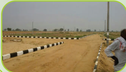
Actual Site Photo
