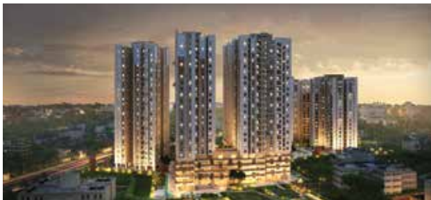
Ozone on South EM Bypass
